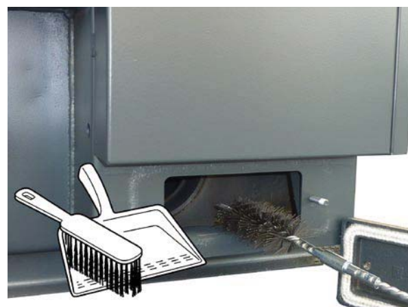
Vorführung der Reinigung des Rauchkanals mit Drahtbürste.
