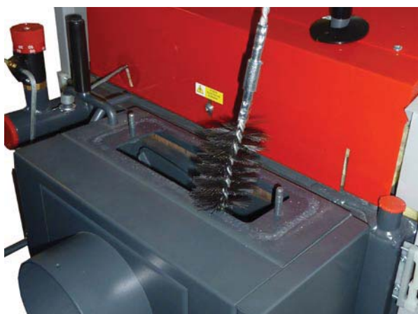
Vorführung der Reinigung des Rauchkanals mit Drahtbürste.
