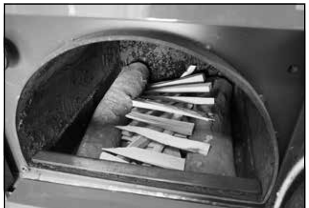
Holzsplitter quer durch die Nachlegekammer über das Zeitungspapier auflegen
