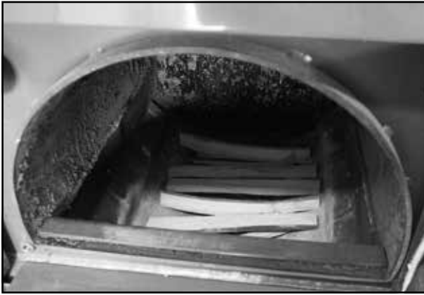
Die Holzsplitter senkrecht zur Öffnung der Vergasungsdüse einlegen
