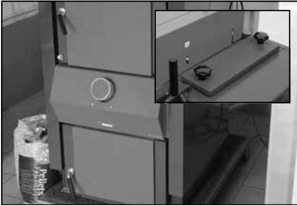
Alle Türen und Reinigungsöffnungen geschlossen
